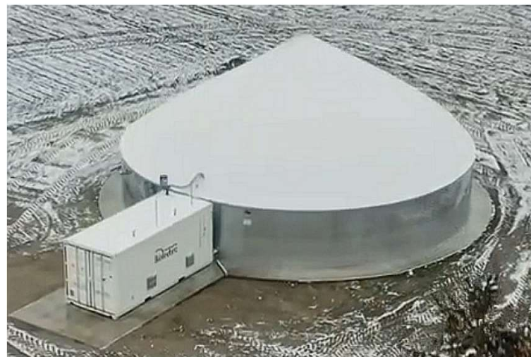
Biogazownia o mocy 44 kWe w Pokaniewie na Podlasiu Źródło: https://naturalnaenergia.plus/mikrobiogazownia-pokaniewo-w-telewizji/
