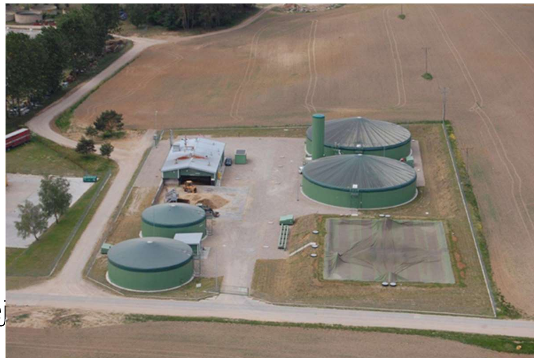
Biogazownia o mocy 1 MWe w Uniechówku (powiat człuchowski) Źródło: Materiały Goodvalley
